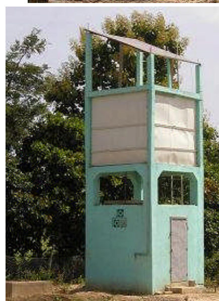
Château d'eau de ce type avec la sortie du forage, à gauche
